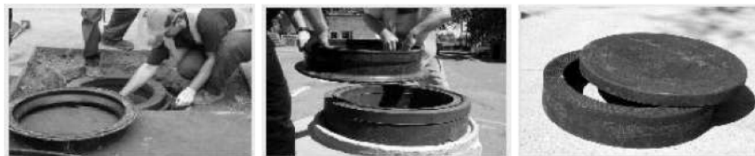
LATERBIT BG PLUS dostarczany w rolkach ok. 15 mb plastycznej uszczelki gotowej do bezpośredniego użycia. Alternatywą jest np. masa uszczelniająca klejąca na bazie polimerów np. SOUDASEAL 235 SF
